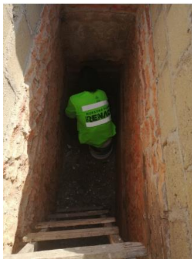
Trabajos dentro de los Cementerios
